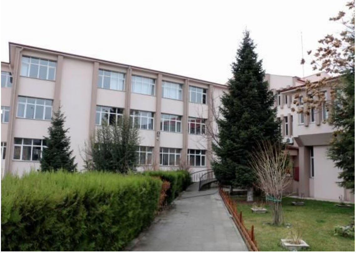
İl Özel İdaresi Hizmet Binası
